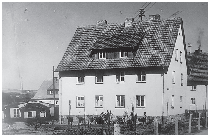
Vordergrund: Simmestraße 2, dahinter Simmestr. 4, links im Bild: Baracke, die abgerissen wurde und Zur Aue 7 errichtet, dahinter links: Umgehungsstr. 12
