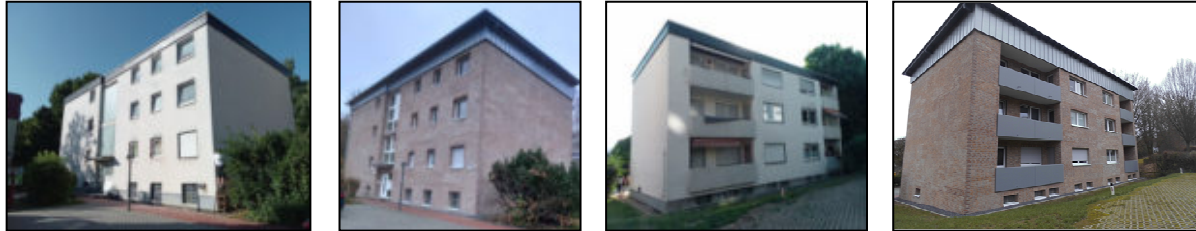
Modernisierung Ernst-Lemmer-Straße 9 in Marburg-Wehrda
